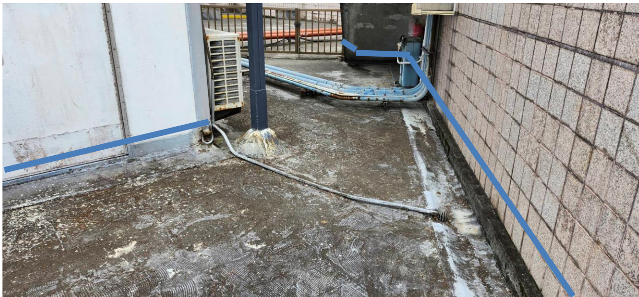
以上圖片為--B棟(電梯機房)上方8樓屋頂平台防水工程施作範圍
