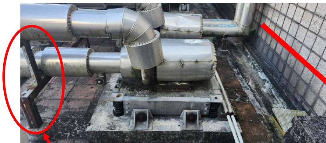
支撐架油漆作業
