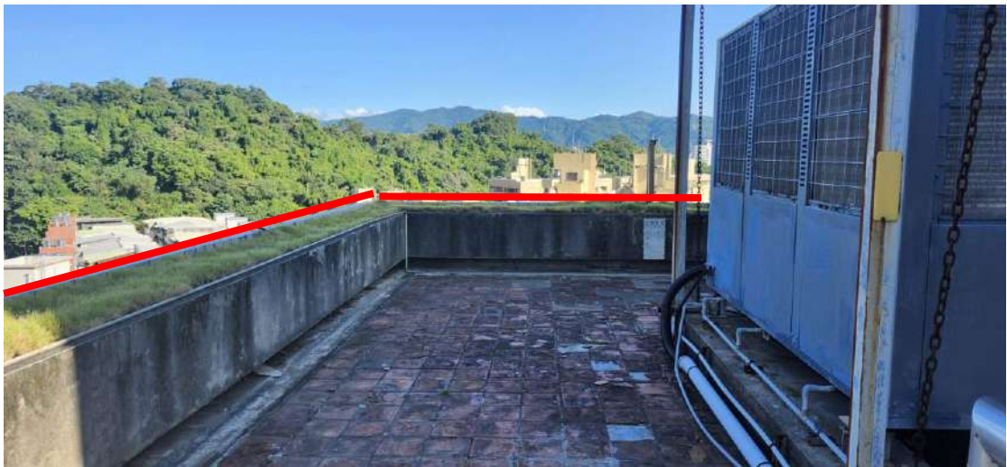
B 棟 7 樓屋頂花台泥土挖除及防水處理照片 -6
