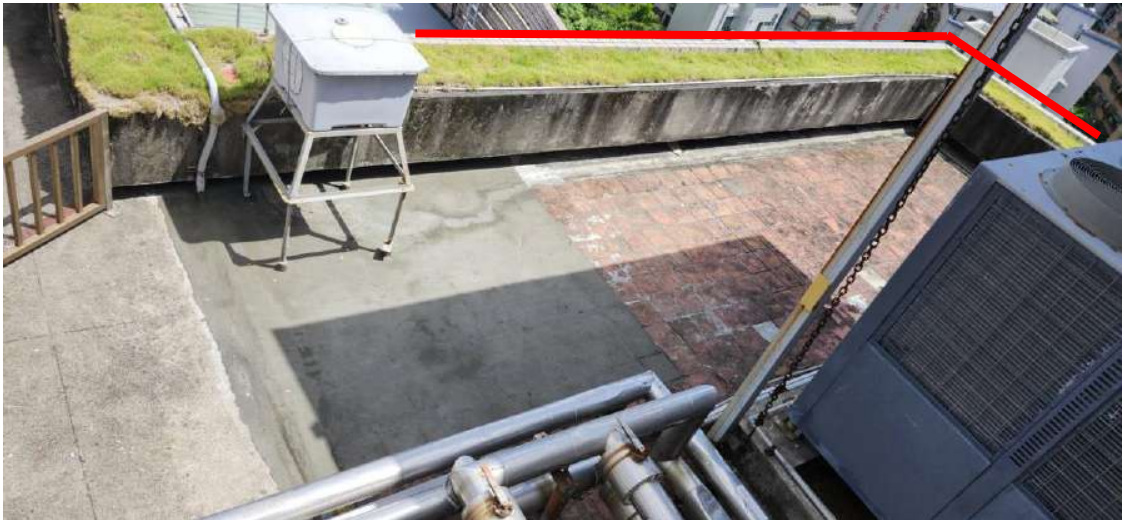
B 棟 7 樓屋頂花台泥土挖除及防水處理照片 -5
