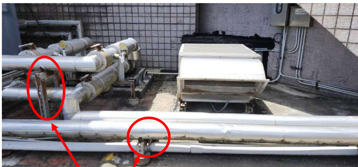
支撐架油漆作業
